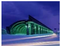
稚内港北防波堤ドーム
