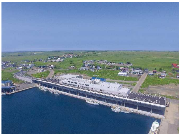
完成した高度品質・衛生管理型の 水産物荷捌施設
