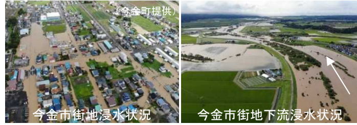
＜令和4年8月洪水被害状況＞
