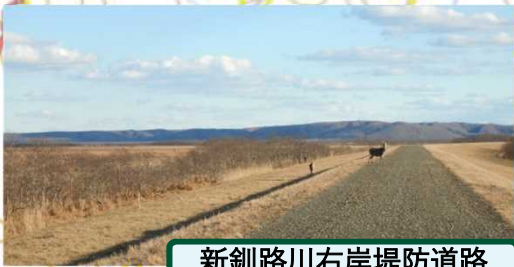
新釧路川右岸堤防道路
