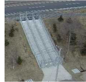
隣接供用区間（国道38号）に 設置した津波避難階段
