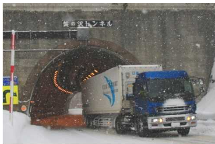
現道（国道5号）の国際海上 コンテナ通行支障箇所
