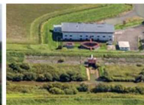
排水機場の排水規制緩和
