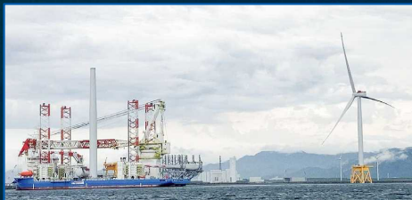
洋上風力発電施設の建設
