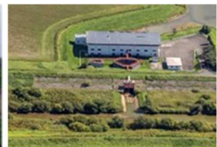
排水機場の排水規制緩和
