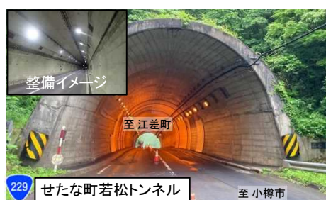
〈道路照明灯のLED化〉
