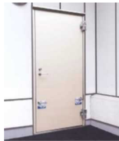
防水扉の設置
