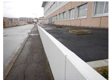
舗装による洗掘防止
