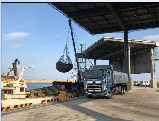
拠点漁港における屋根付き岸壁の整備
