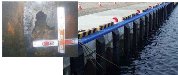
矢板が腐食した係留施設の老朽化対策例
