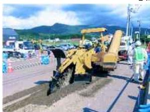
トレンチャー機械による掘削の試験施工
