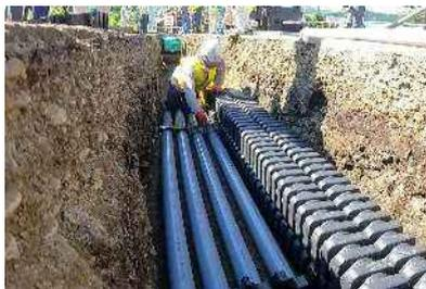
浅層埋設、角型多条電線管の施工
