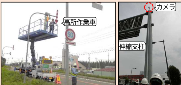
高所作業車や伸縮カメラによる点検 → 人力による診断
