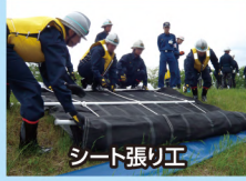
シート張り工
