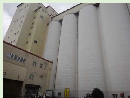
三ツ輪運輸飼料原料貯蔵施設
