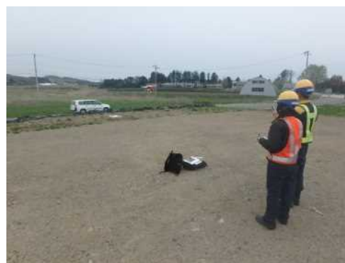
↑ UAV測定の検証を行い現場での実効性を確認
