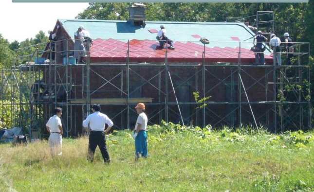
歴史的建造物を修復する作業は、技術の継承と技術者の育成に繋がっています
