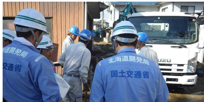
調査箇所事前踏査の様子②(道路・木原地区)
