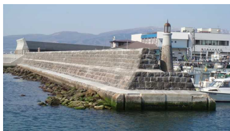
函館漁港船入潤防波堤 (北海道唯一の石積み構造の防波堤、コンクリートブロックとのハイブリット構造)
