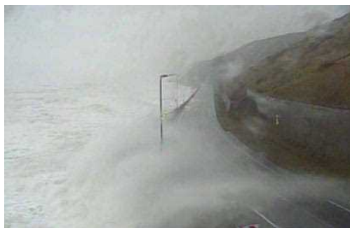
▲越波発生状況（写真②）
