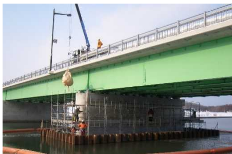
緊急輸送道路上の橋梁の耐震補強
