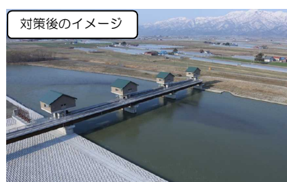
施設更新等による防災対策の実施
