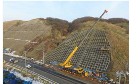
道路斜面の防災対策
