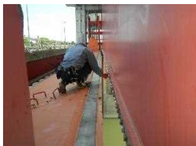
施設の点検（水門ゲート設備）
