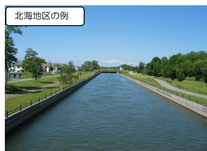
更新整備した用水路
