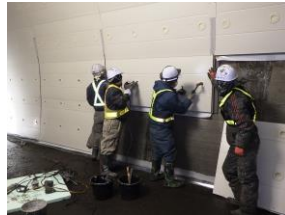
トンネルの修繕状況
