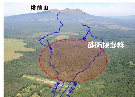
樽前山寛生川砂防堰堤群の整備
