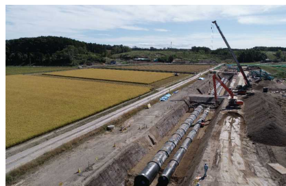
用水路（パイプライン）の復旧工事
