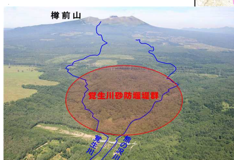
覚生川砂防堰堤群(建設中)
