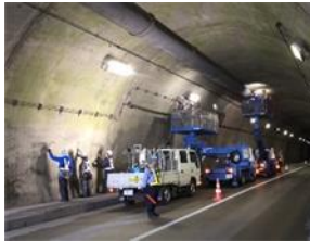
トンネルの点検状況
