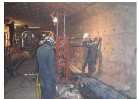
函渠耐震対策施工状況
