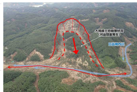
ひだかほろないがわ 日高幌内川 大規模土砂崩落の状況
