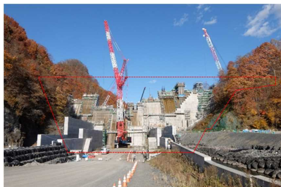
本体工事状況（令和元年10月撮影）
