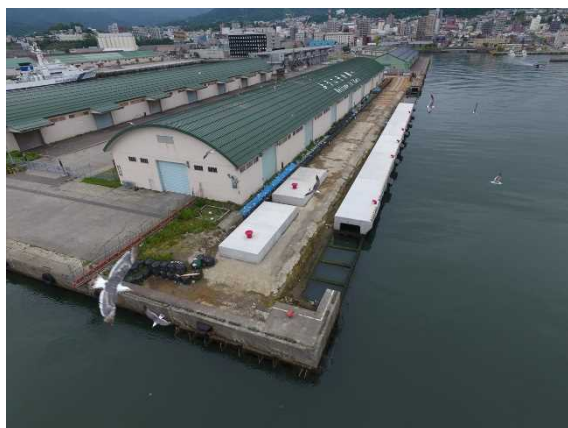
小樽港クルーズ船岸壁整備状況 (平成30年7月)
