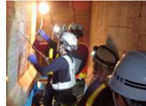
地方公共団体職員向け講習会状況
