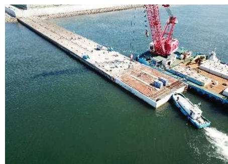
釧路港新西防波堤の延伸
