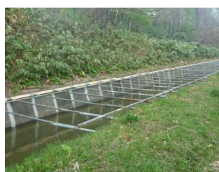
側壁傾倒への応急措置（切梁） （倶知安幹線用水路）
