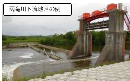
防災対策が必要な頭首工
