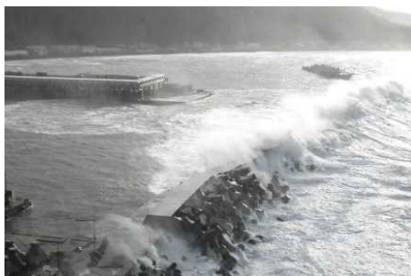
防波堤の越波状況（ウトロ漁港）
