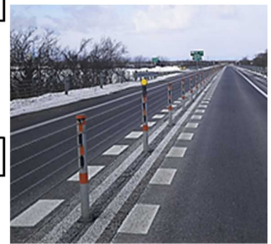
【ワイヤロープの設置状況】
