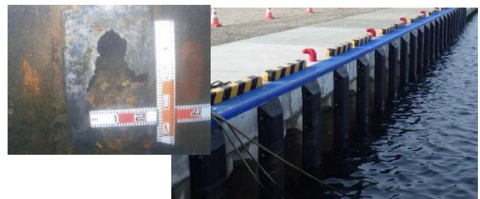
矢板が腐食した係留施設の老朽化対策例
