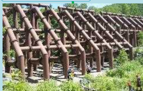
富良野川2号透過型堰堤
