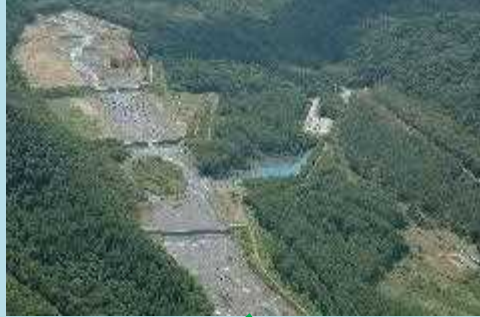
美瑛川床止工群とブロック堰堤（青い池）
