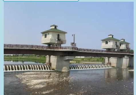
常呂川第2頭首工
