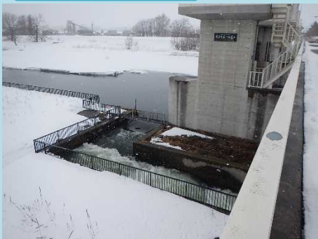
常呂川第1頭首工
