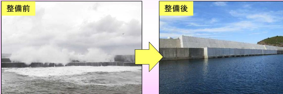
防波堤の拡幅や嵩上げによる越波対策
