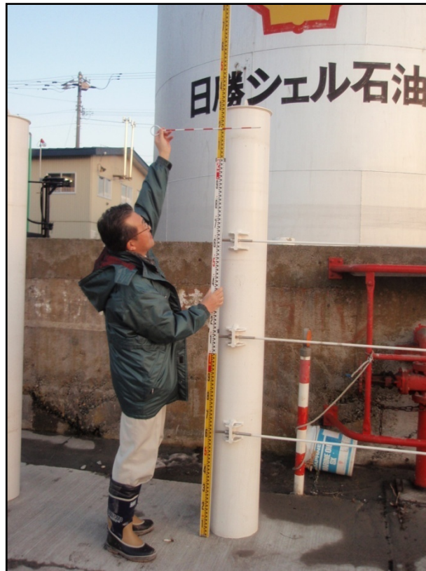
港奥部津波スクリーンの津波痕跡（地盤から 2.3m程度）
