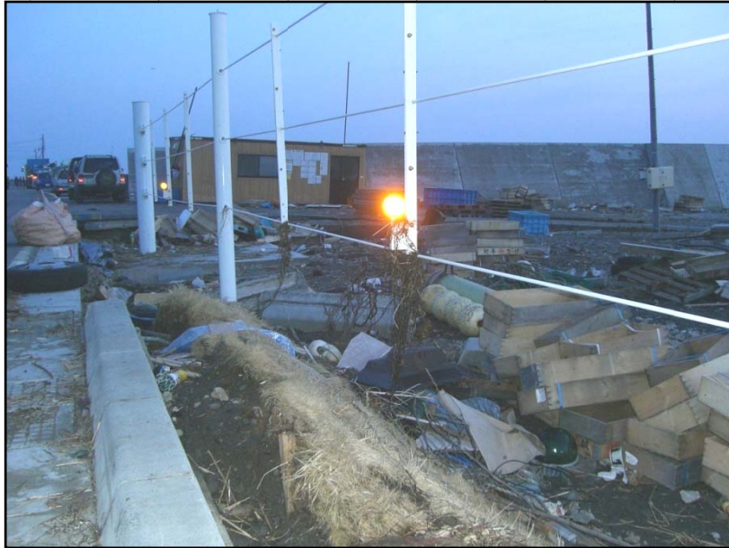
津波スクリーンの下端横ワイヤーに海藻付着（地盤から 1.0m程度）
