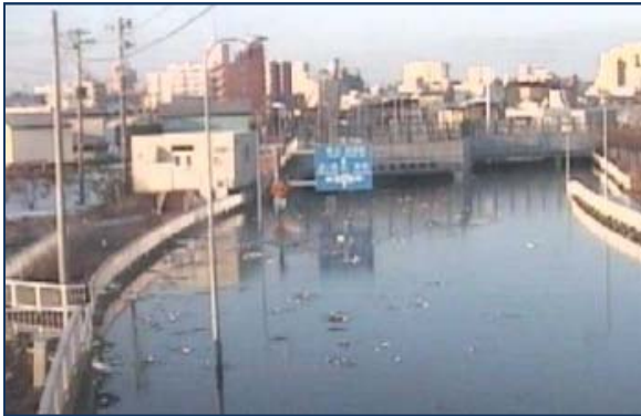
一般国道44号 釧路市 旭アンダーパス(冠水状況)
