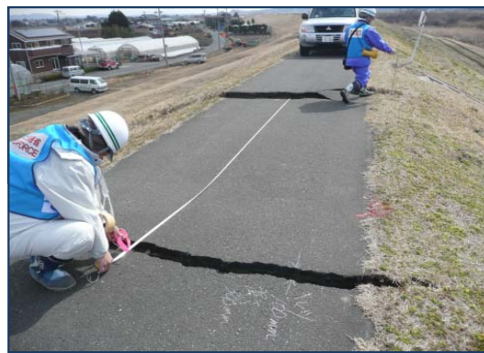
【宮城県吉田川】堤防点検
