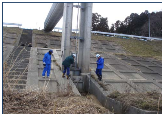
【宮城県吉田川】樋門点検
