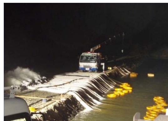
【宮城県東松島市】 津波浸水箇所の排水作業
