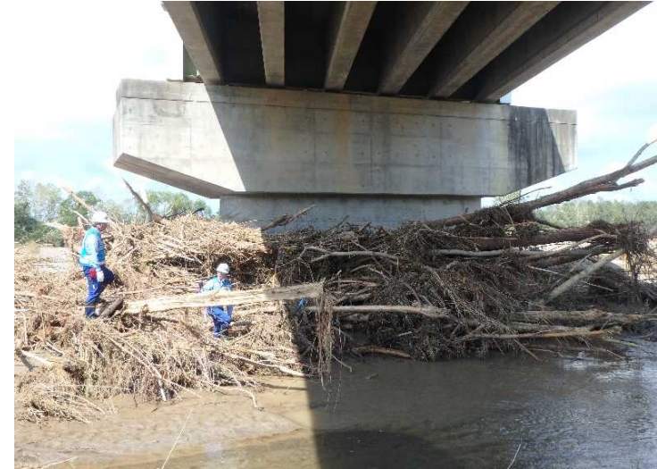
《四国地方整備局(道路班)》 芽室町芽室大橋の現地調査
