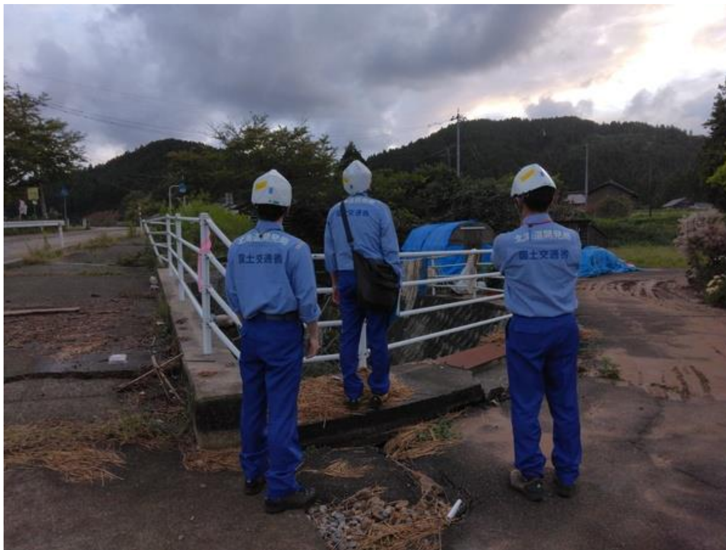
石川県輪島市の現地調査
