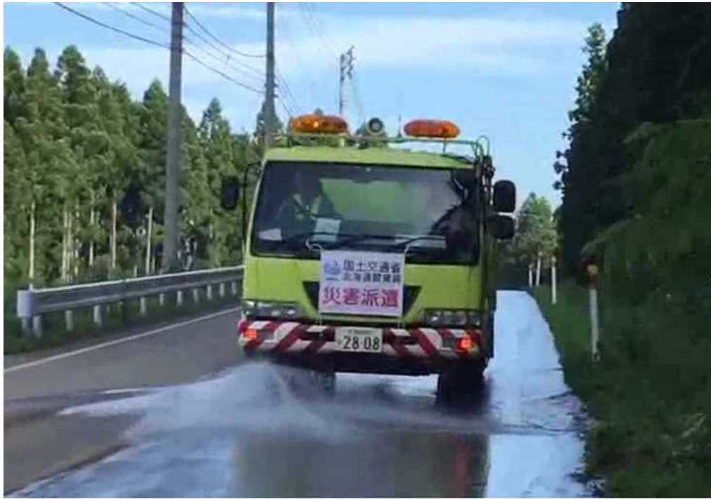
路面清掃作業を実施 (活動場所：秋田県大仙市)
