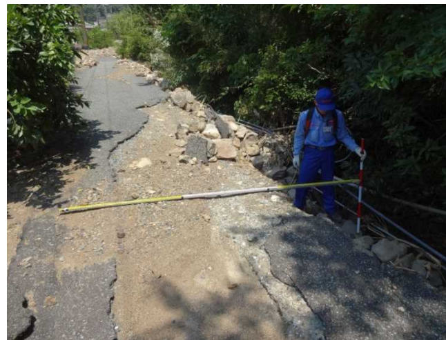
道路現地調査の様子
