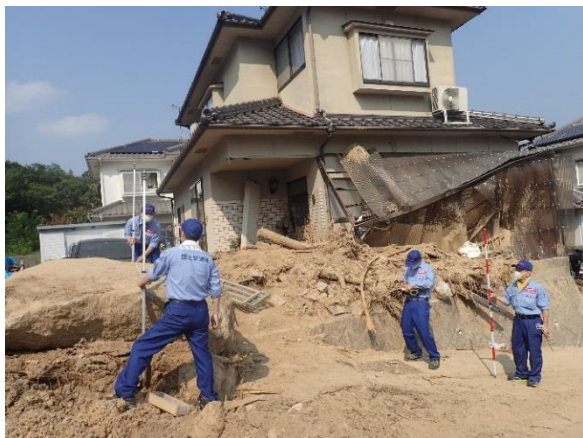
道路現地調査の様子①(熊野町)
