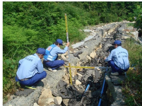
道路現地調査の様子③(東広島市)
