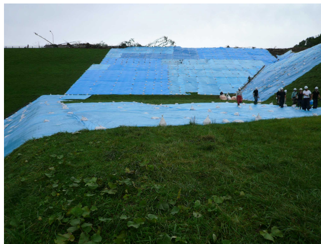
ダム保護シート張りを概ね完了
