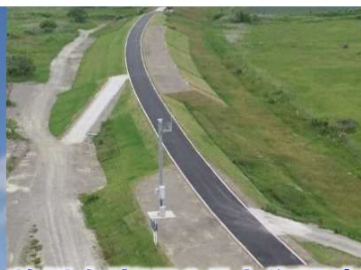
鵡川左岸KP0.7本復旧完了
