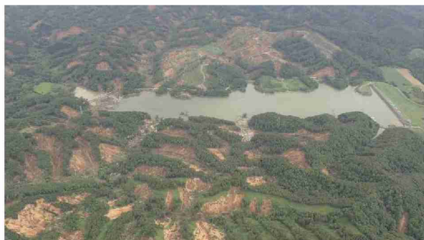
写真 2-14 瑞穂ダムの被害状況
