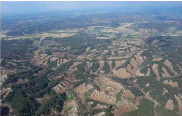
図 1-1 胆振東部地震による土砂崩落の様子
