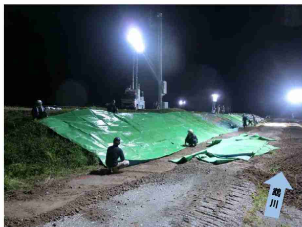
写真 3-8 シート張工施工状況（①工区）
