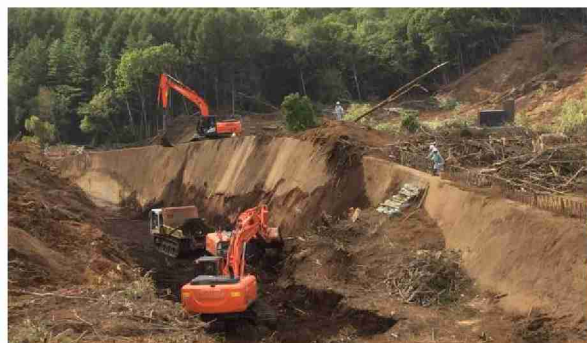
写真 3-13 自衛隊の協力による余水吐の倒木除去作業と土砂撤去作業
