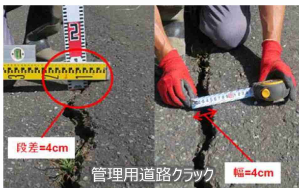
写真 2-13 夕張スーパーダム被災状況
