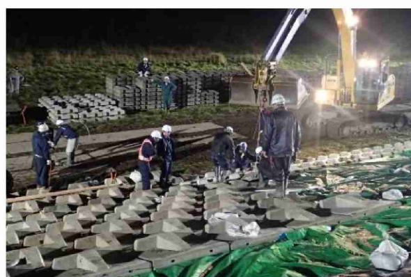
写真 3-10 24 時間体制での緊急復旧工事の様子
