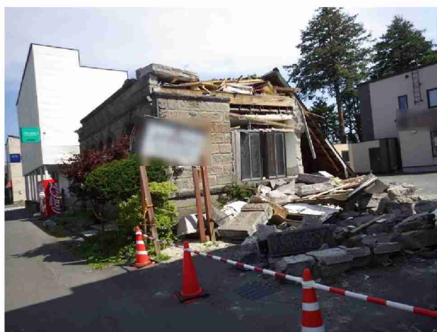
写真 2-1 建物被害の様子（上：札幌市清田区里塚、下：安平町）
