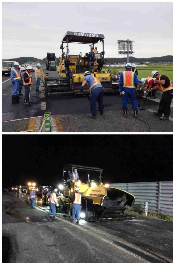
写真 3-12 路面変状の緊急復旧工事
