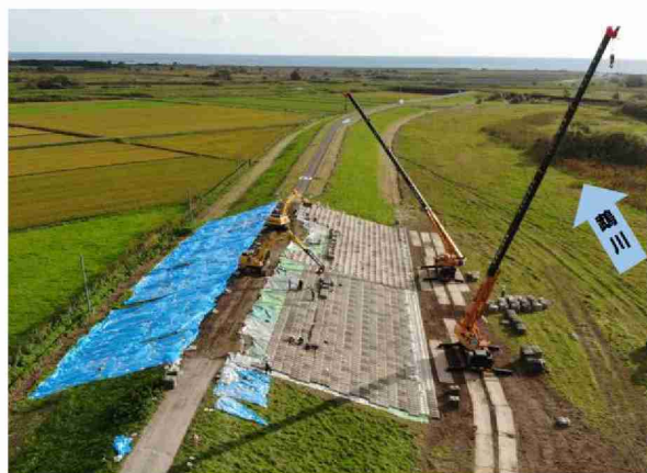
写真 3-9 大型連節ブロック敷設状況（④工区）
