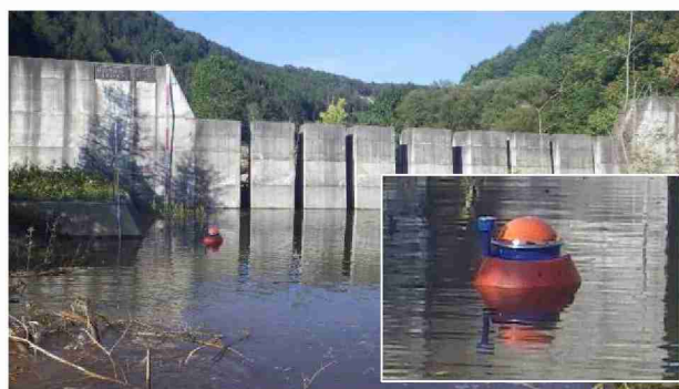
写真 4-23 投下型水位観測ブイの設置
