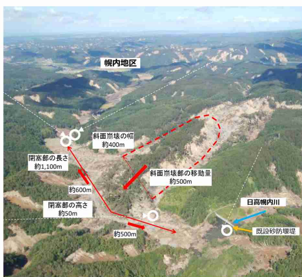
図 4-14 日高幌内川の河道閉塞状況
