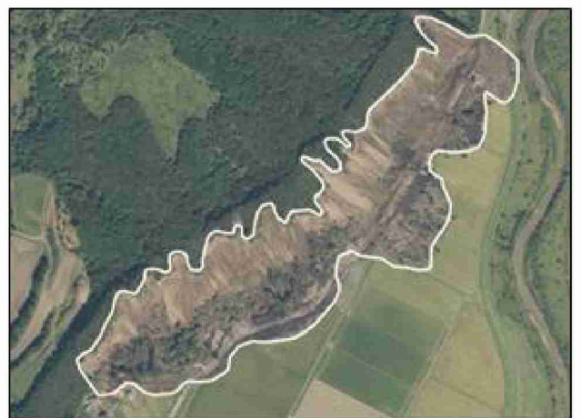
図 5-3 厚真町吉野周辺の斜面崩壊・堆積範囲 上：斜面崩壊・堆積分布図 下：9 月 11 日撮影の空中写真に斜面崩壊・堆積範囲の外縁を重ねた図
