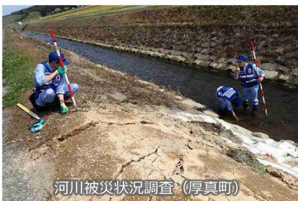
写真 4-8 河川被災状況調査の様子
