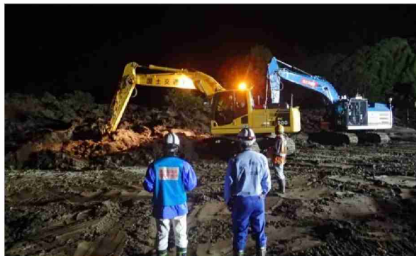
写真 4-15 夜を徹した掘削作業状況(厚真町)
