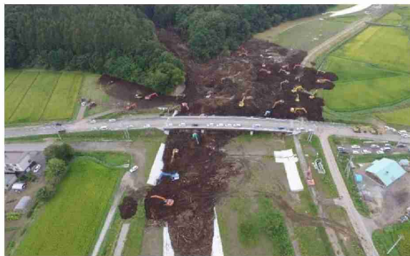
写真 4-14 河道道掘削作業状況(厚真町)
