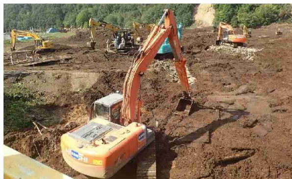
写真 4-13 重機による河道掘削作業状況(厚真町)
