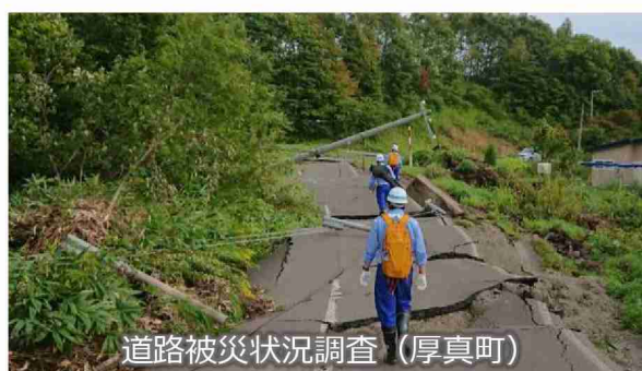
写真 4-7 道路被災状況調査の様子
