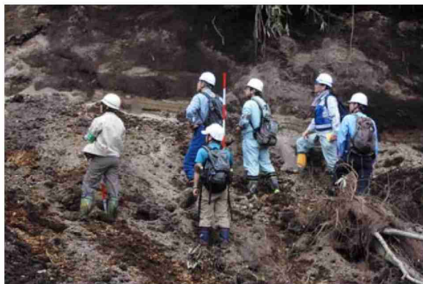
写真 5-4 崩壊箇所の現地調査
