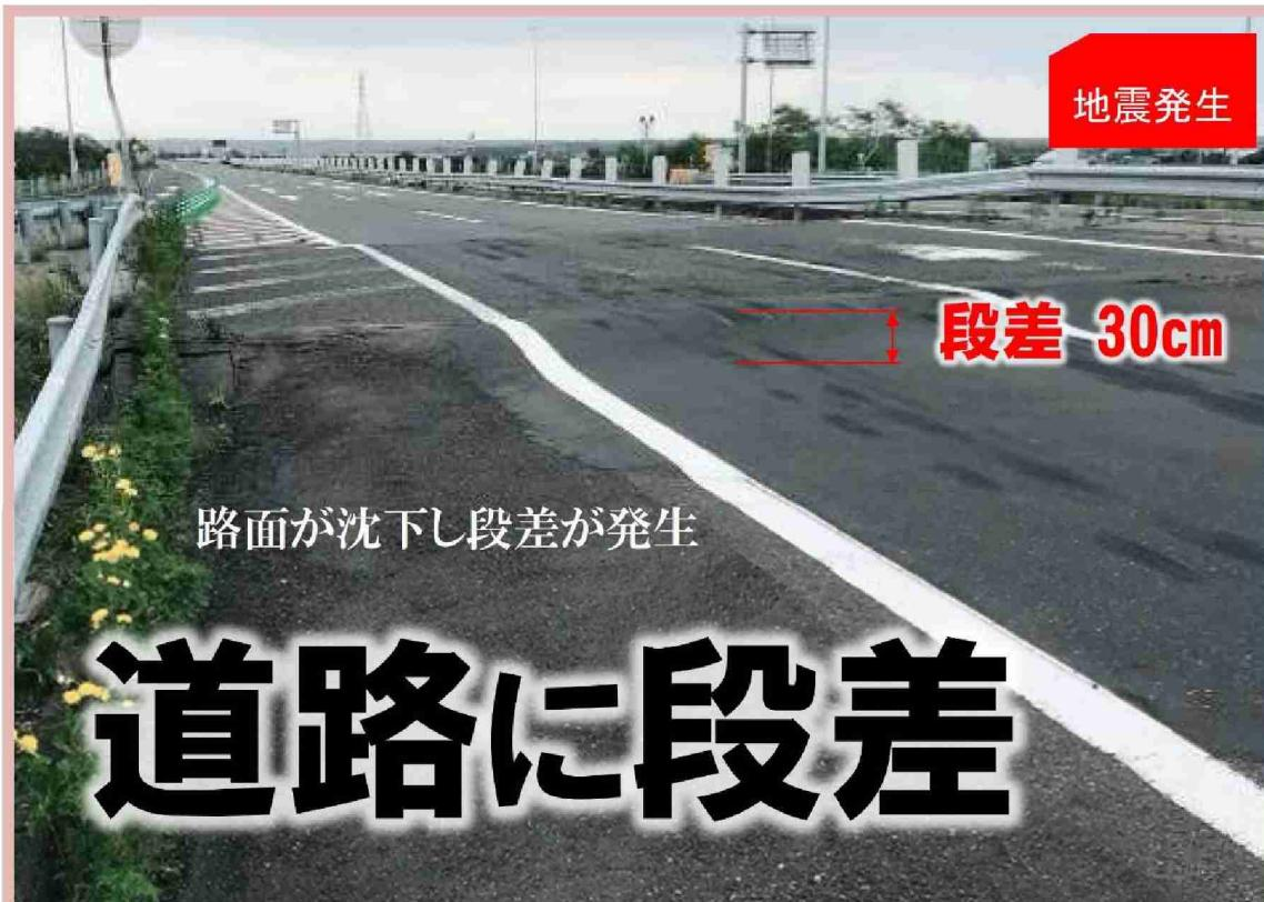
地震発生直後から、国が管理する日高自動車道(沼ノ端西IC～日高厚賀IC)を全面通行止めとし、地震時点検を実施。その点検結果により路面変状による段差等が確認されました。
