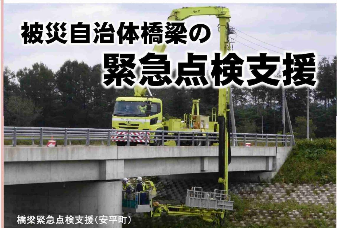
地震発生直後から、橋梁点検車により被災自治体(安平町、むかわ町、厚真町)の橋梁について緊急的に24箇所の点検を実施し支援。
