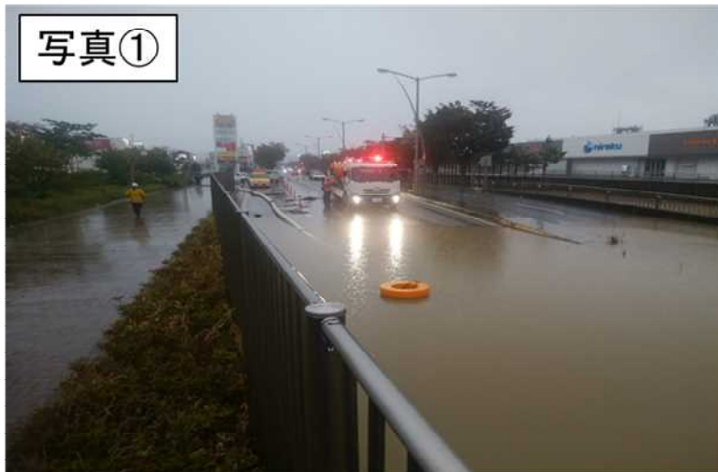
排水ポンプ車による排水作業 (福島県郡山市向河原町(向河原大町線アンダーパス))
