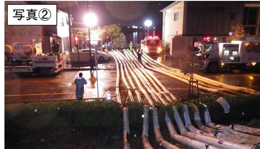
排水ポンプ車による排水作業 (福島県郡山市田村町金屋上川原(古川第一池))
