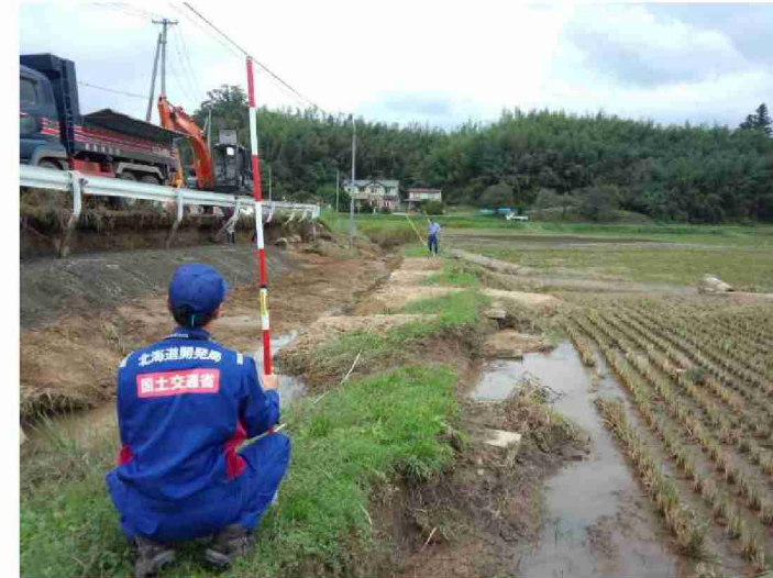
被災状況調査 (宮城県角田市)
