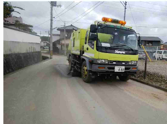
路面清掃車等による路面清掃作業 (宮城県丸森町)
