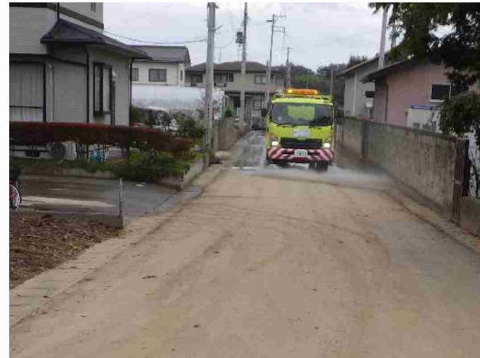
路面清掃車等による路面清掃作業 (福島県相馬市)
