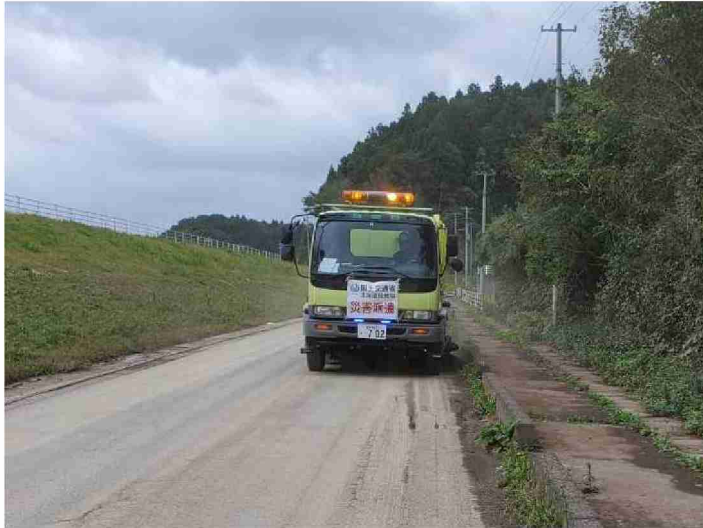
路面清掃車等による路面清掃作業 (宮城県角田市)
