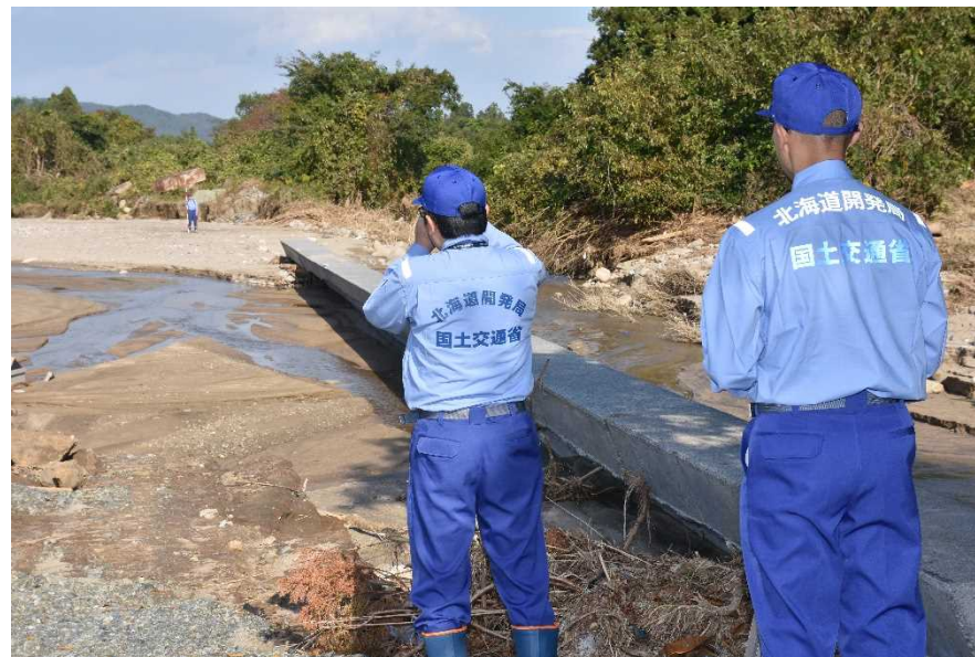
被災状況調査 (宮城県丸森町)
