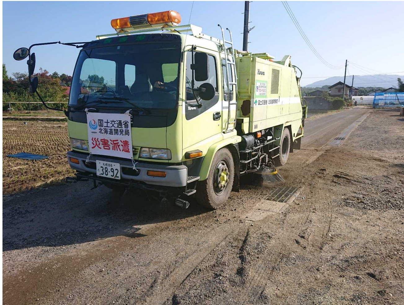
路面清掃車による路面清掃作業 (福島県須賀川市)
