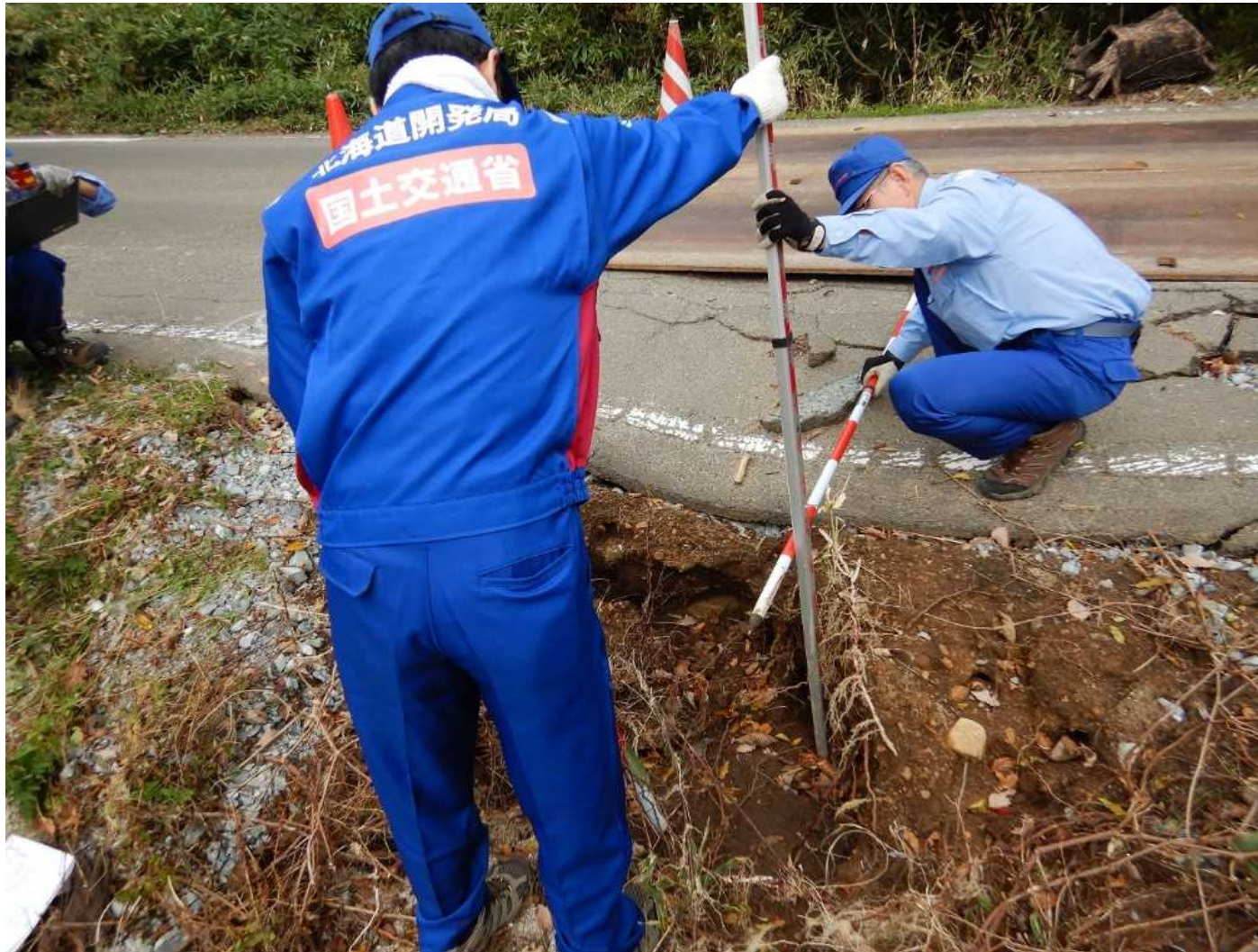
被災状況調査 (宮城県丸森町)
