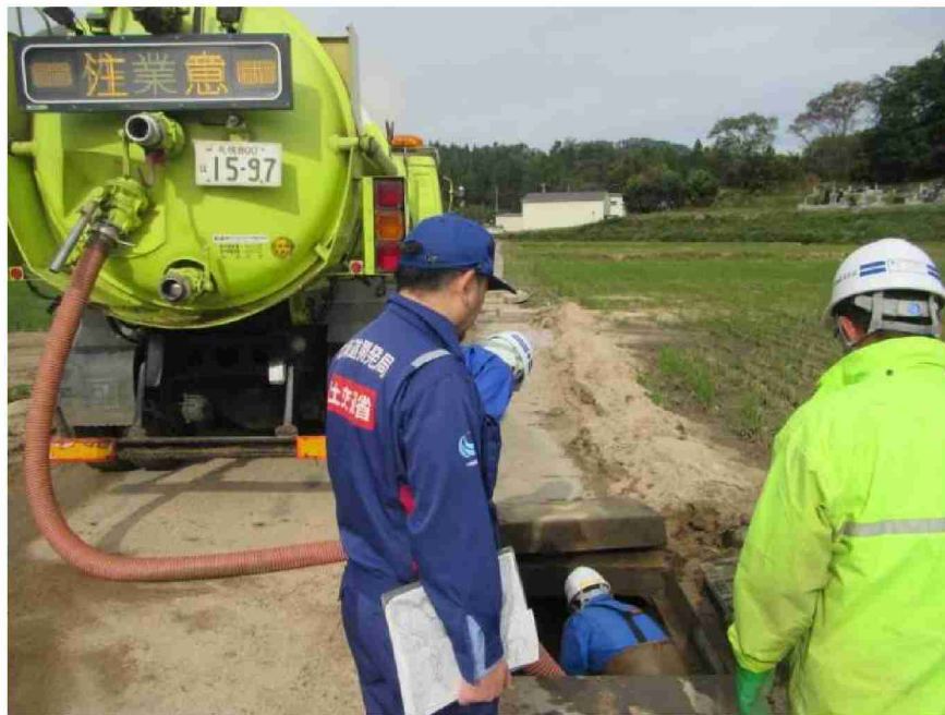
側溝清掃車による側溝清掃作業 (宮城県丸森町)
