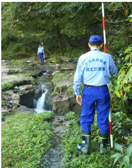
被災状況確認
