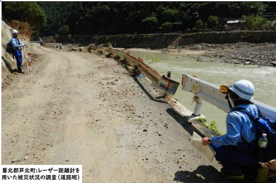
葦北郡芦北町:レーザー距離計を用いた被災状況の調査(道路班)
