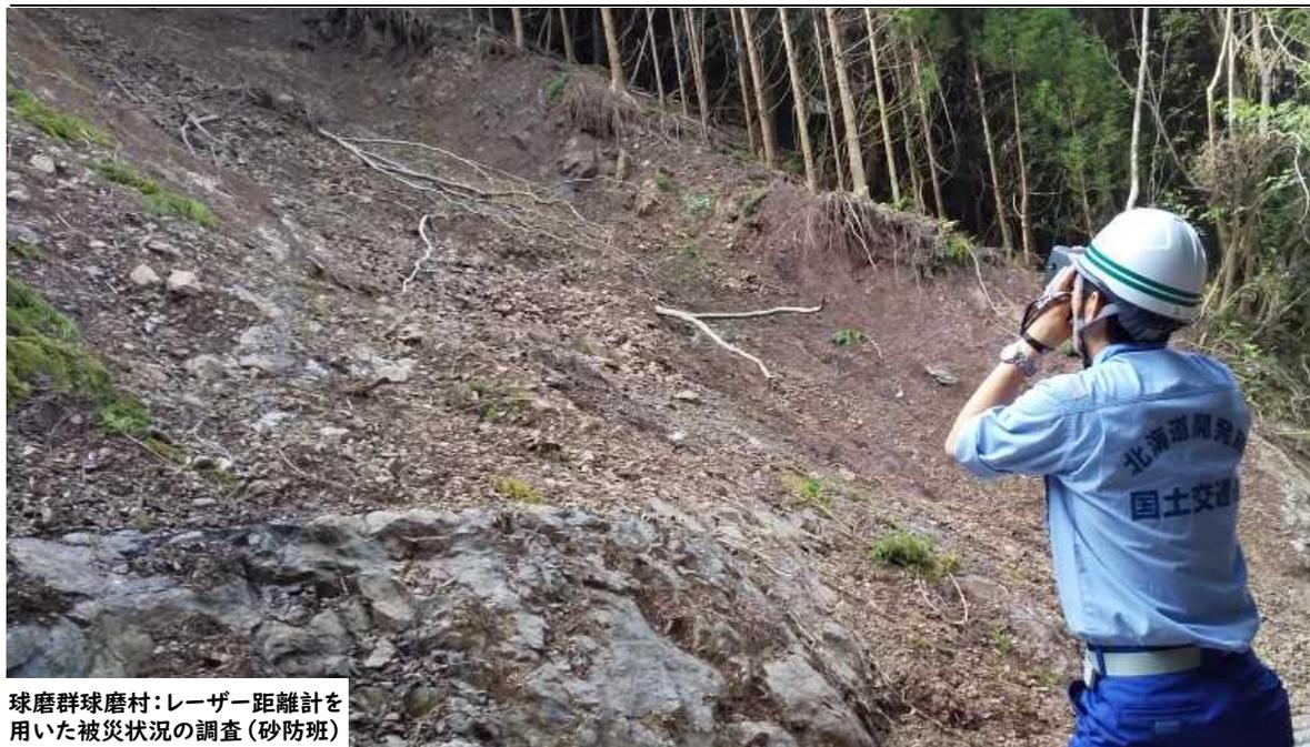
球磨群球磨村：レーザー距離計を用いた被災状況の調査(砂防班)
