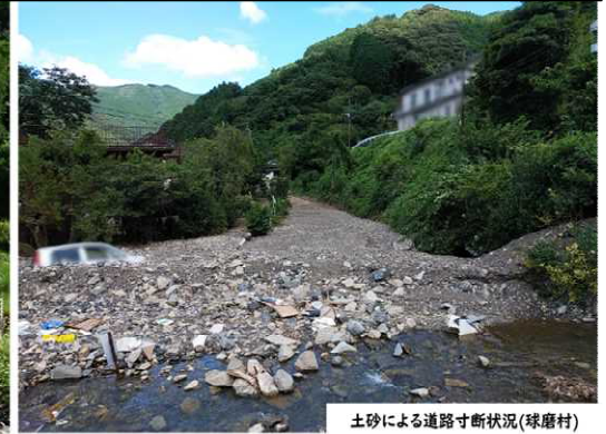
土砂による道路寸断状況(球磨村)
