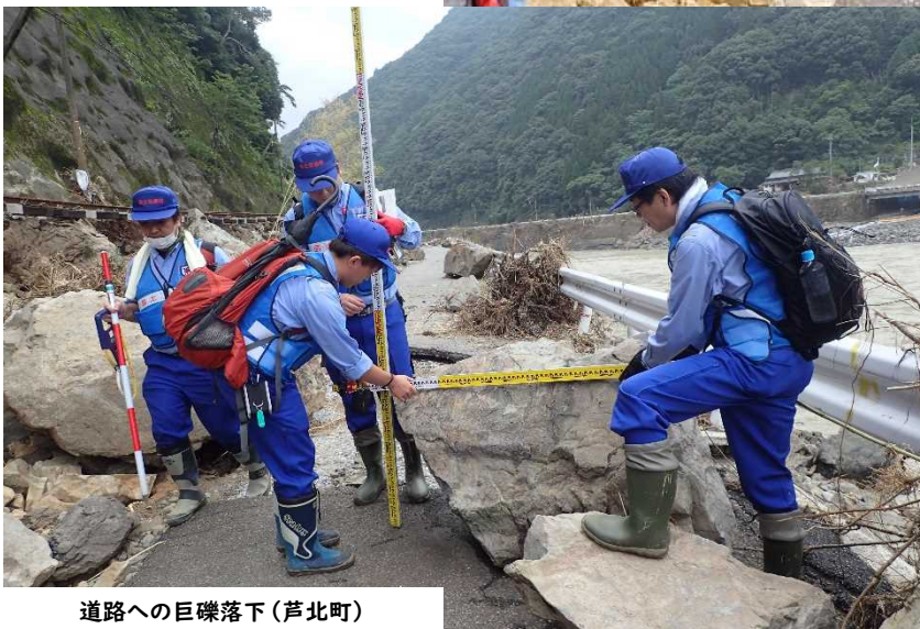
道路及び沿線線路の洗掘(芦北町)
