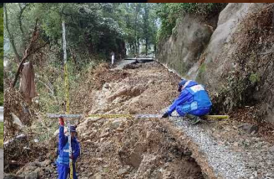
路肩崩壊箇所の被災状況調査(県道球磨田浦線)
