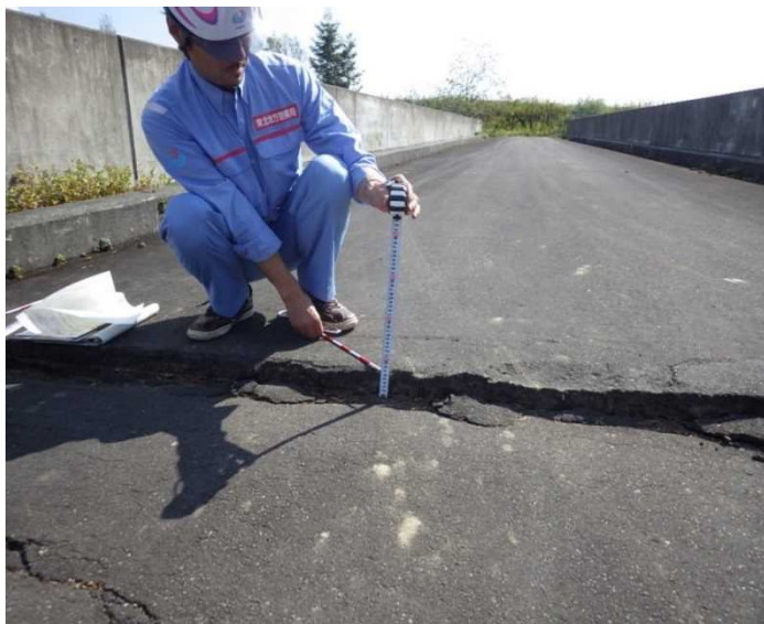
橋梁点検実施状況(旭1号橋)
