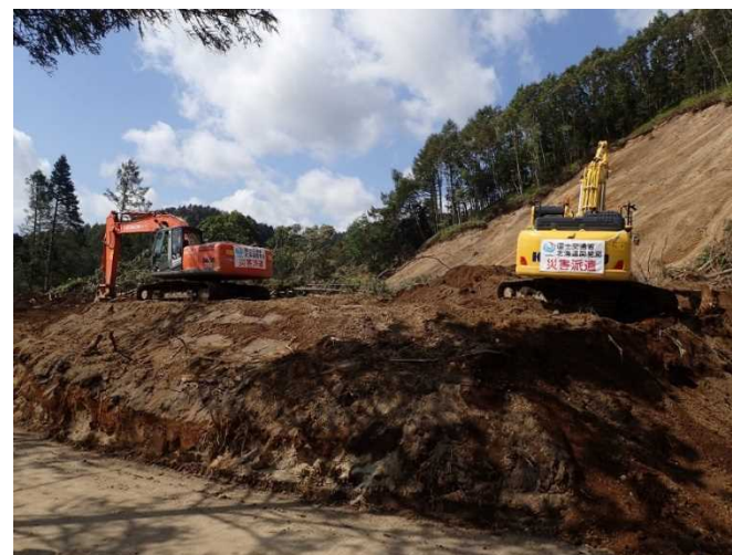
河道掘削（厚真川）上流側状況
