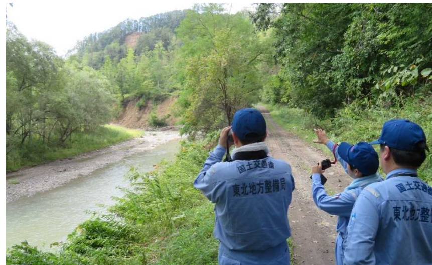
土砂崩落概況調査
