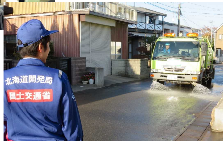
散水車による路面清掃作業 (福島県相馬市)
