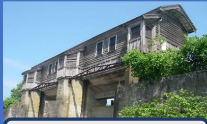
旧岩保木水門
