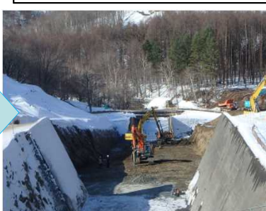
洪水吐復旧工事（R3.2）
