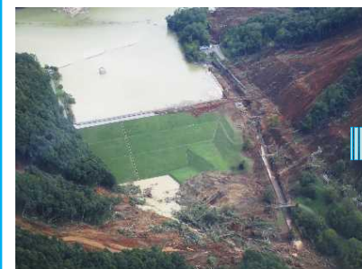
厚真ダムの被災
