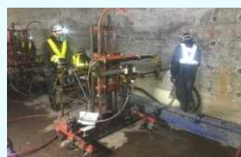
函渠耐震対策(新千歳空港)
