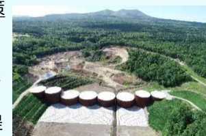
樽前山覚生川2号砂防堰堤 （苫小牧市）
