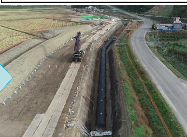
導水路復旧工事（R2.10）
