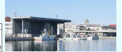
令和元年10月暫定供用 紋別港 屋根付き岸壁
