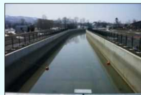
老朽化した農業用水路の改修
