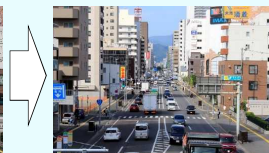
道路の防災性の 向上 (札幌市 国道12号)
