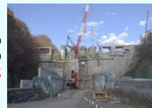
工事中の平取ダム（平取町）
