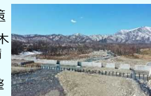
十勝川水系戸鷹別川 第2号砂防堰堤（常広市）
