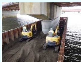
緊急輸送道路上の橋梁の耐震補強
