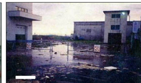
下水処理場越波浸水被害(H6.9)
