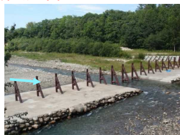
6号床固 流木対策工 完了
