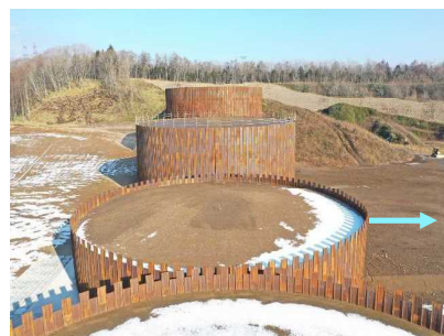
覚生川3号堰堤 施工後
