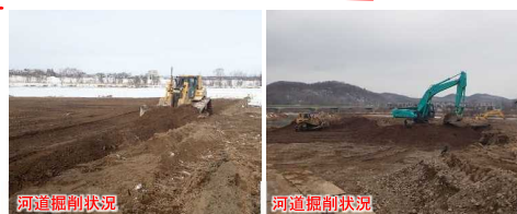
河道掘削状況
