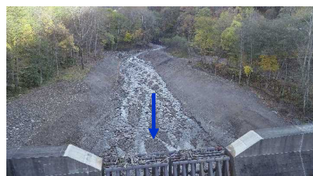
リクマンベツ川第1号堰堤 除石後
