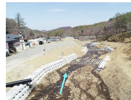
床固工群の整備
