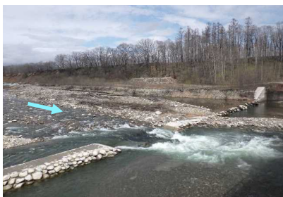
6号床固 流木対策工 着手前
