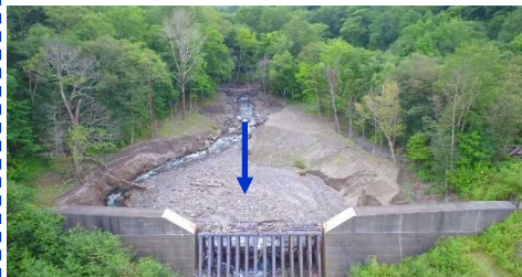
リクマンベツ川第1号堰堤 除石前
