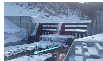
砂防堰堤の整備
