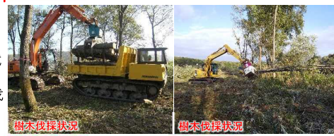
樹木伐採状況
