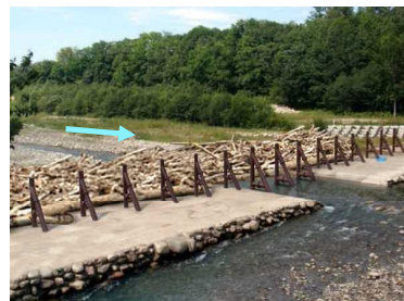
流木対策工 出水後 捕捉イメージ
