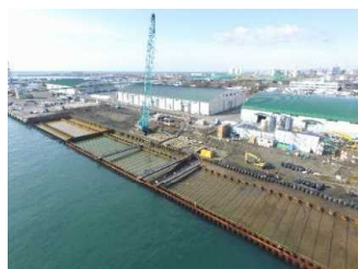
地盤改良工事実施状況
