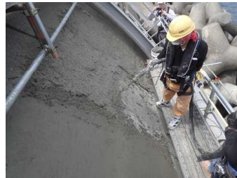
アーチ部の補修状況
