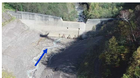
黒岳沢川第1号堰堤 除石後
