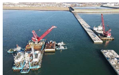
新西防波堤整備状況
